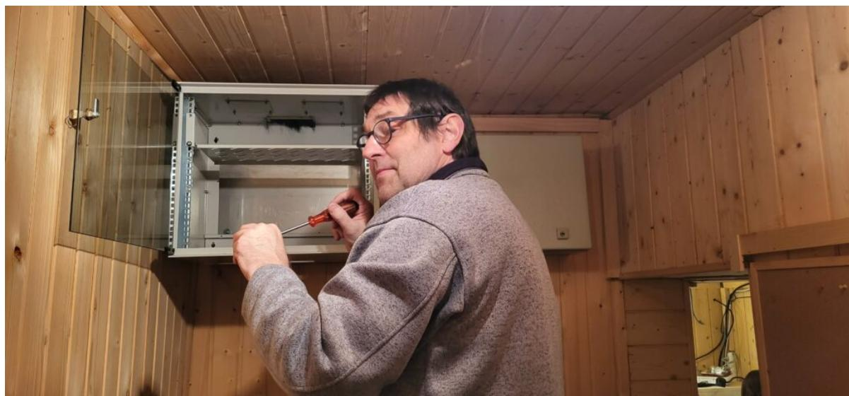
Das Rack für den 70cm Fusion-Repeater wurde im Vorräum an die Wand montiert (vorher stand es unter dem Operateur-Pult), daneben der Schrank für die Notstrom - Akkus. So haben wir beim Pult wieder etwas mehr
